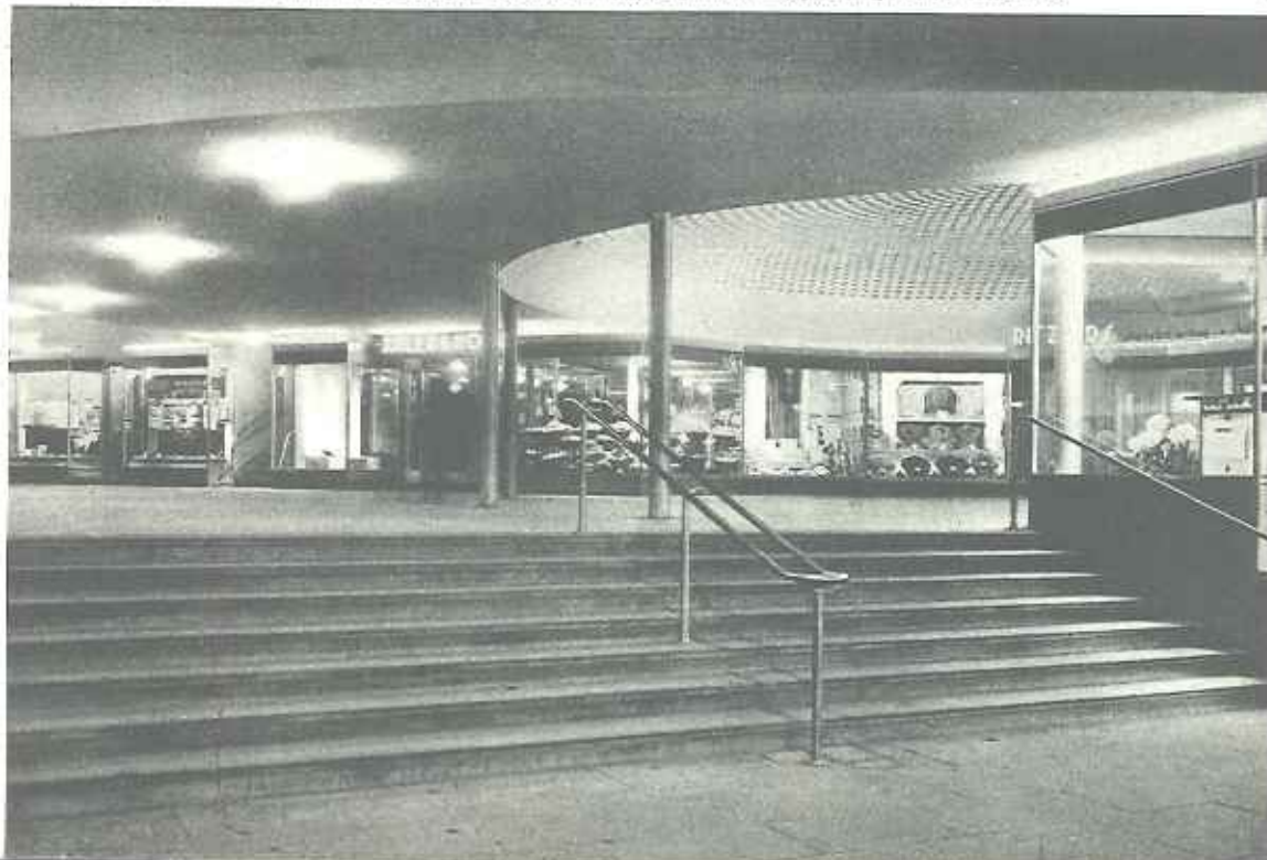
Passaggio delle Botteghe Turchine: a destra la cupola di vetrocemento e i negozi disposti a semicerchio
